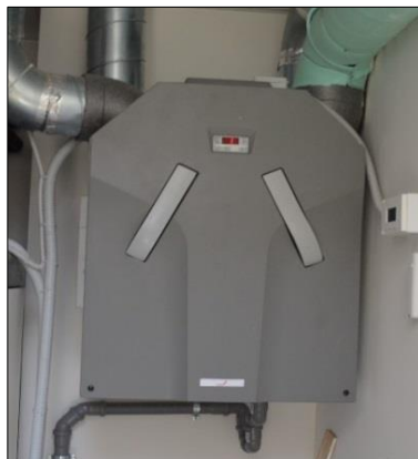
Ventilazione meccanica controllata a flussi incrociati
