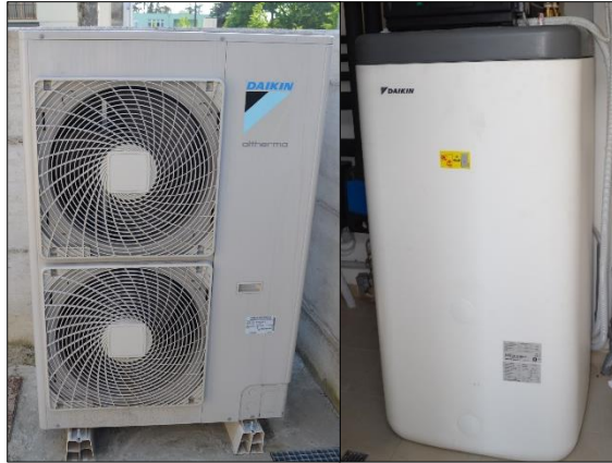
Pompa di calore reversibile aria-acqua per riscaldamento, raffrescamento, produzione ACS (potenza termica nominale = 11 kW, COP nominale = 4.19)
