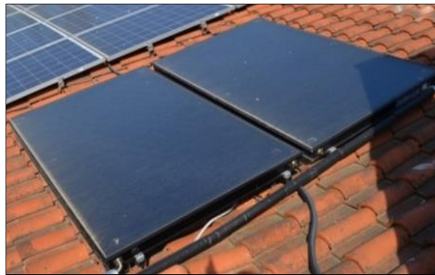
2 collettori solari piani per produzione ACS ( A = 1.8 \text{ m}^2 , \eta_0 = 0.783 , \alpha_1 = 4.25 \text{ W/m}^2\text{K} , \alpha_2 = 0.0057 \text{ W/m}^2\text{K}^2 )
