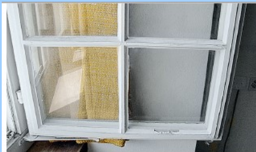
Stucco per finestre contenente amianto Stucco per finestre (stucco a base di olio di lino).
